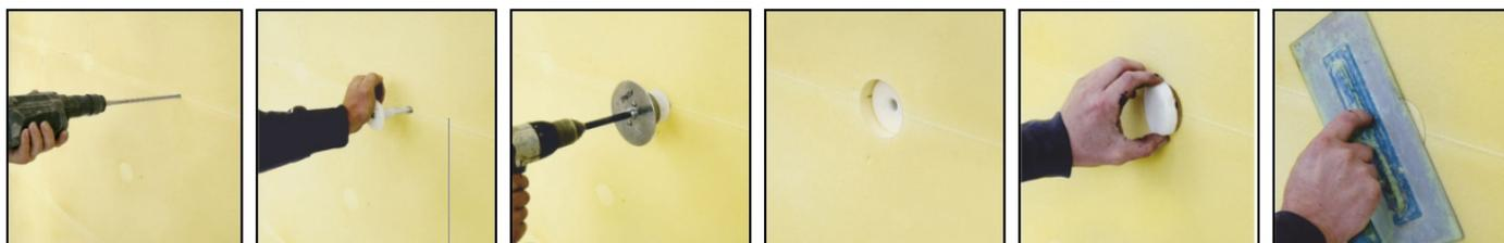
1. Vyrvtání otvoru    2. Osazení hmoždinky    3. Ukotvení hmoždinky    4. Ukotvena hmoždinka    5. Osazení víčka    6. Zatláčení víčka
